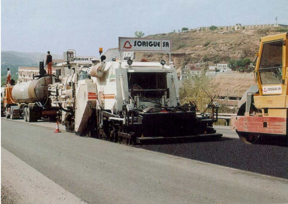
RECICLADO IN SITU DE PAVIMENTOS ASFÁLTICOS
