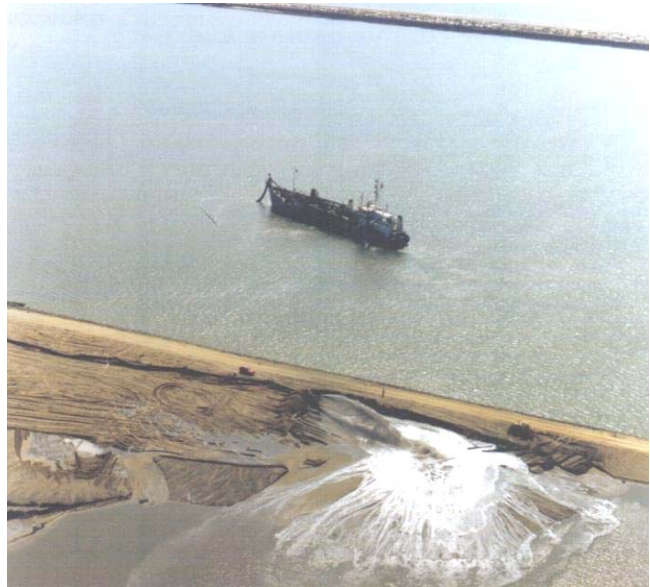
RELLENO DE UN RECINTO CON MATERIALES DRAGADOS EN EL CANAL DE ACCESO AL PUERTO DE HUELVA
