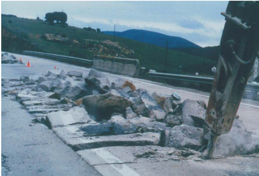
DEMOLICIÓN DE PAVIMENTOS DE HORMIGÓN PARA SU RECICLADO
