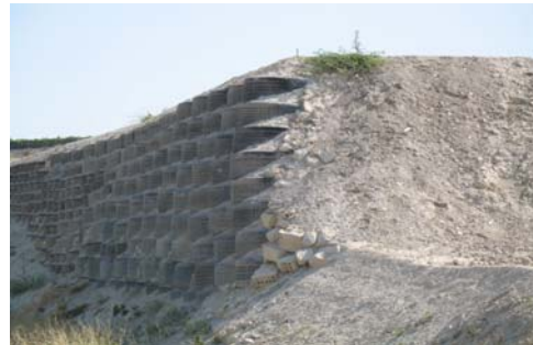
NFU construcción de taludes
