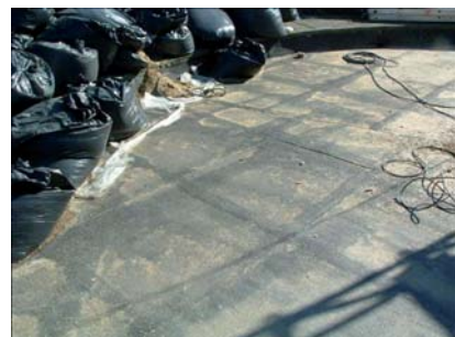
Figura A1.27 Telas asfálticas y productos bituminosos
