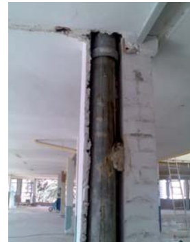
Figura A1.25 Canalizaciones de agua, bajantes de aguas residuales, canalones, conductos de humos
