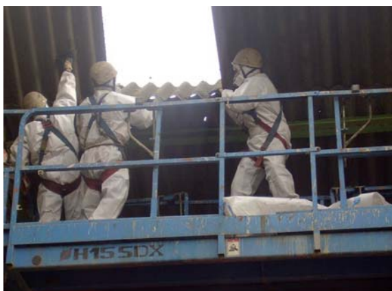
Figura A3.22 Desmontaje de piezas enteras para la retirada de una cubierta de fibrocemento
