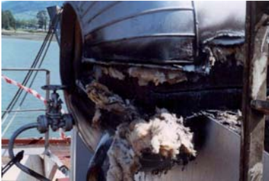
Figura A1.37 Aislamientos de maquinaria (Borra de amianto)
