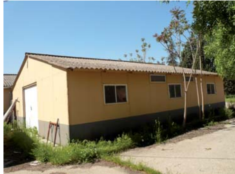
Figura A1.19 Edificios prefabricados (paredes y cubierta)
