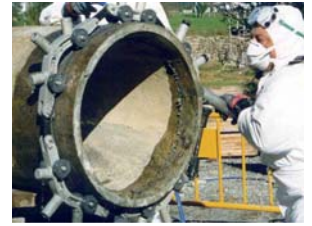
Figura A3.18a Figura A3.18b Herramienta manual de corte para conductos de fibrocemento y detalle de utilización
