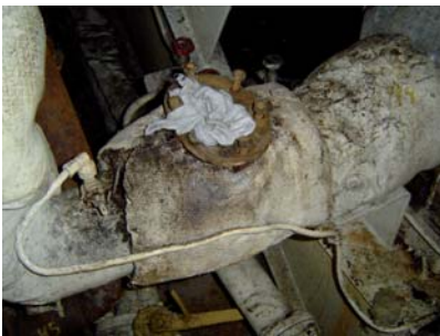
Figura A1.29 Detalle de calorifugado (textiles)
