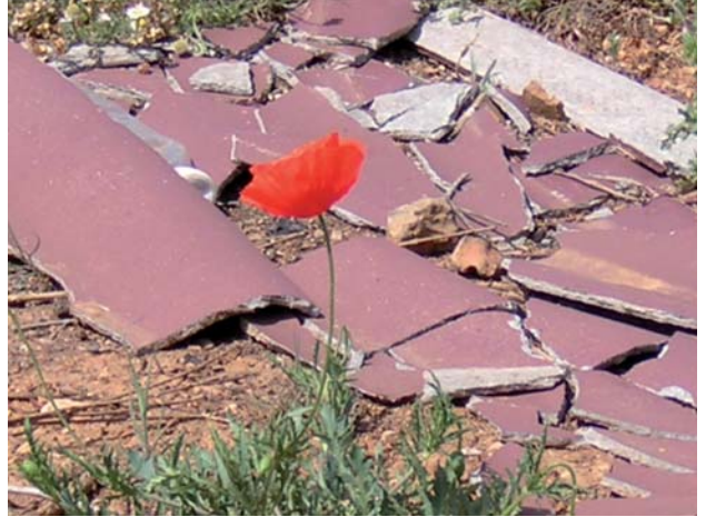
Figura A3.27b Residuos incontrolados de fibrocemento
